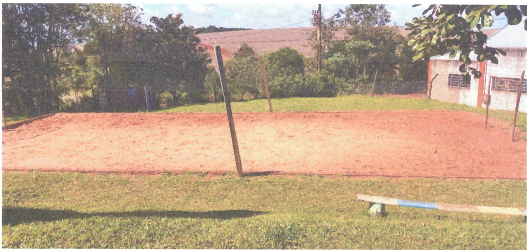
Local de construção da quadra coberta
